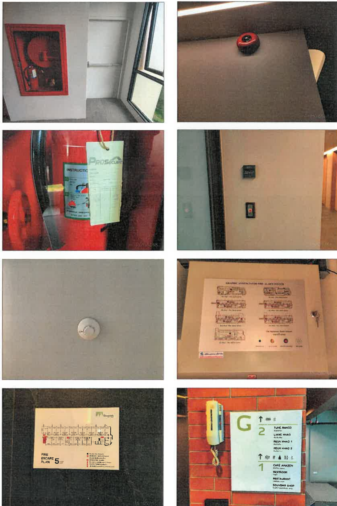
รูปที่ 3.8-1 ระบบป้องกันและเตือนอัคคีภัย
